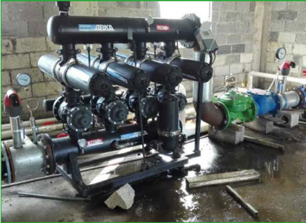
控制首部采用组合式空气阀和 423 型阀门 - 广西
