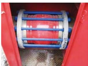
某些阀门可能需要从系统拆卸下来才能进行维修，阀门内部零部件很多，需要专业工具和专门培训才能进行现场维修。消防测试后进行阀门复位可能比较复杂并且需要较长时间。
